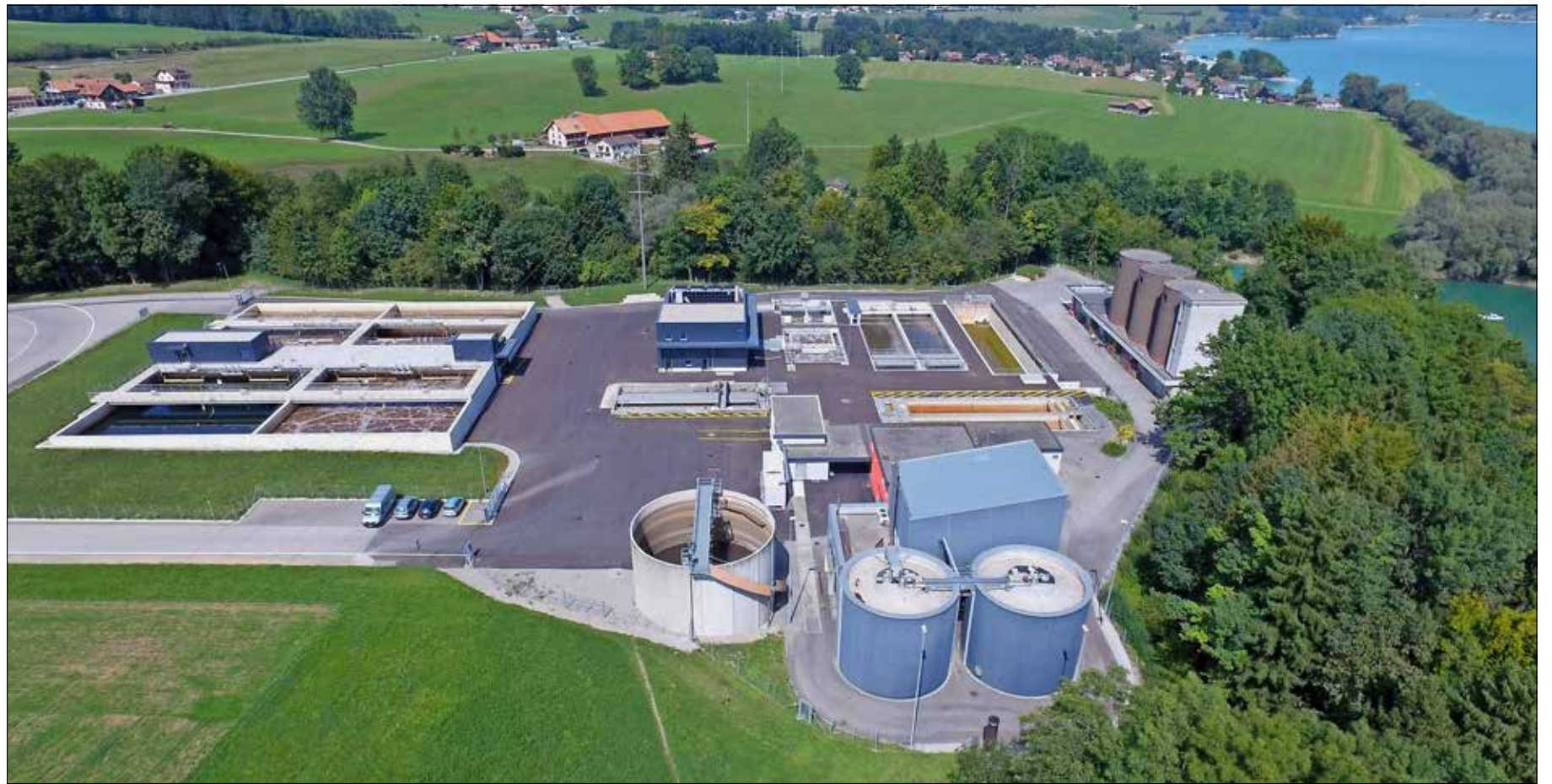
Une centrale de chauffe sera construite dans l'enceinte de la station d'épuration de Vuippens. Sur le long terme elle servira à densifier le réseau de chauffage à distance. GESA
